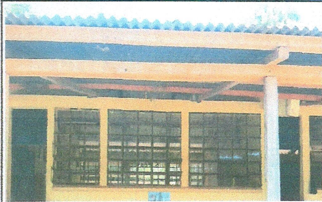
Foto 1: Mejoramiento de estructura de techo
