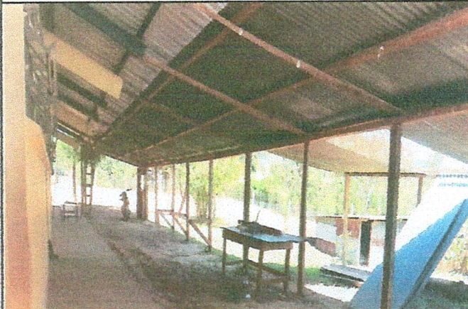
Foto 3: Cambio cubierta de lamina a troquelada calibre 26mm
