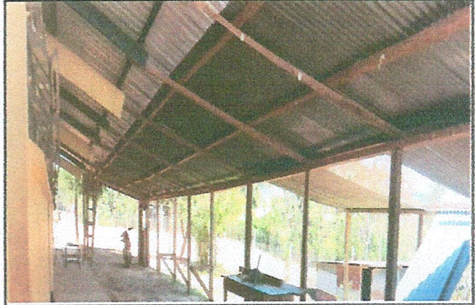
Foto 4: Mejoramiento estructura de techo del patio
