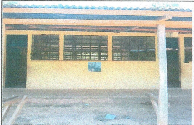
Foto 4: Patio frontal mejorara con losa de piso
