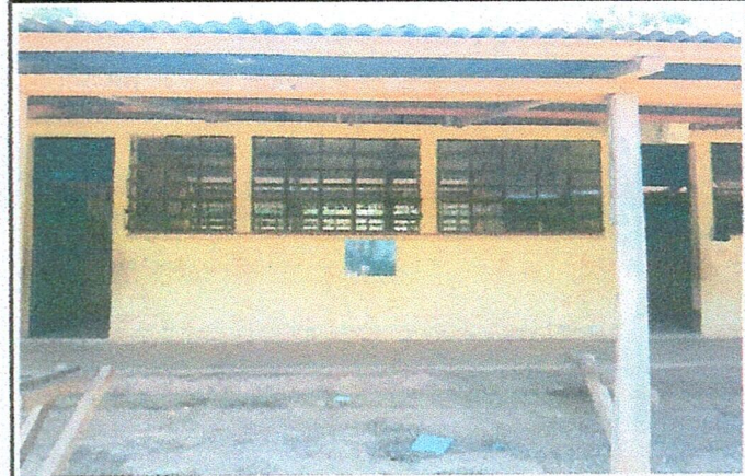
Foto 4: Mejoramiento cubierta de lamina patio
