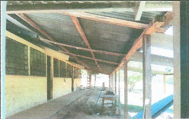
Foto 1: Cambio cubierta de lamina
